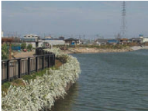
オアシス整備事業 森池護岸（堺市）
