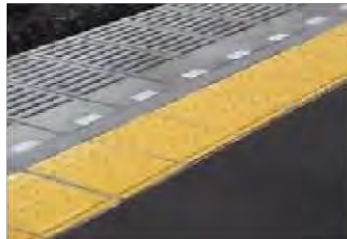
写真：内方線付き点状ブロック
