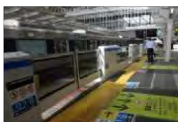
写真：可動式ホーム柵
